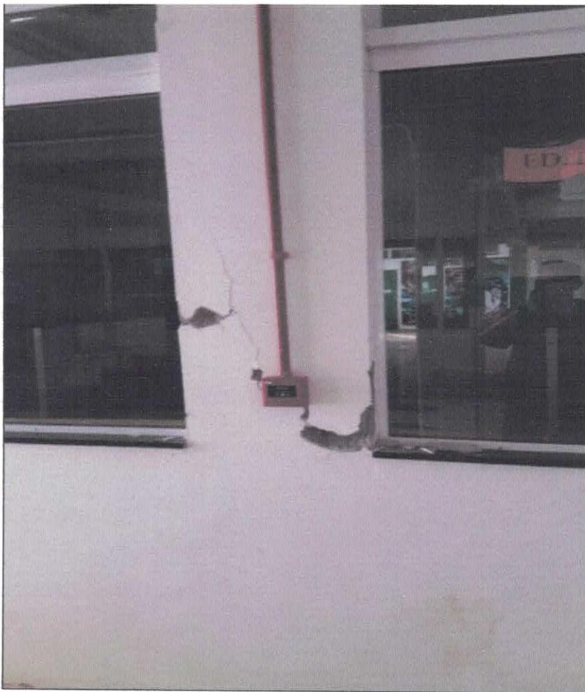
**Figura 02 – Imagem da alvenaria com fissuras.**
