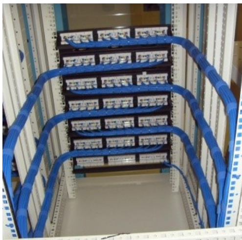
Fig. 3: Detalhe da organização de cabos UTP no rack já conectorizados.
