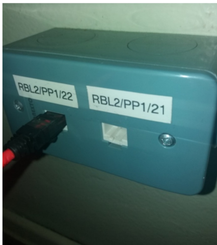
Fig. 7: Ponto de rede x2 devidamente identificado.
