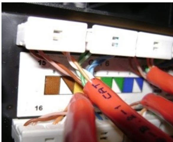
Figura 3: Exemplo de execução de conectorização no patch panel.
