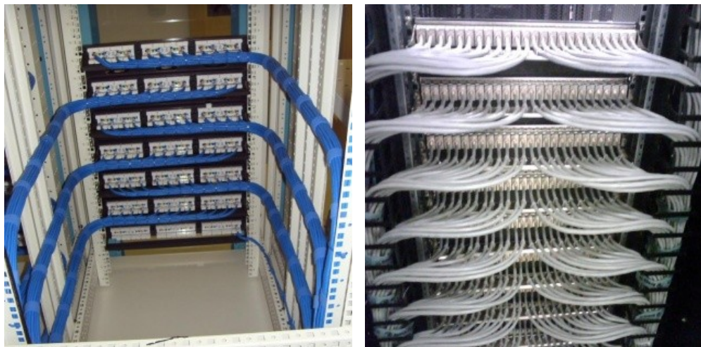
Figura 2: Detalhe da organização de cabos UTP no rack já conectorizados.
