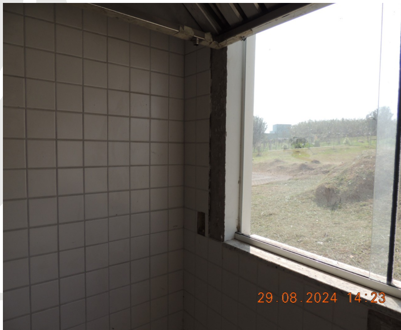
Foto 16 – Finalizar a instalação dos revestimentos cerâmicos nas molduras das janelas.
