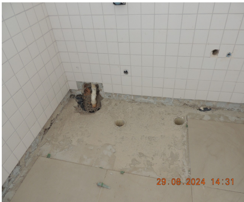
Foto 37- Instalação dos pisos de porcelanato, finalização do revestimento cerâmico nas paredes.
