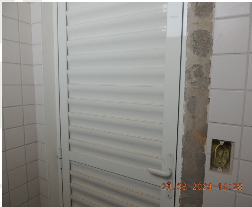
Foto 34- Finalização das instalações de azulejos nas bordas das portas.
