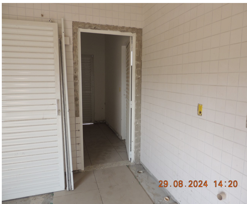
Foto 13 – Finalizar a instalação dos revestimentos cerâmicos nas molduras das portas.
