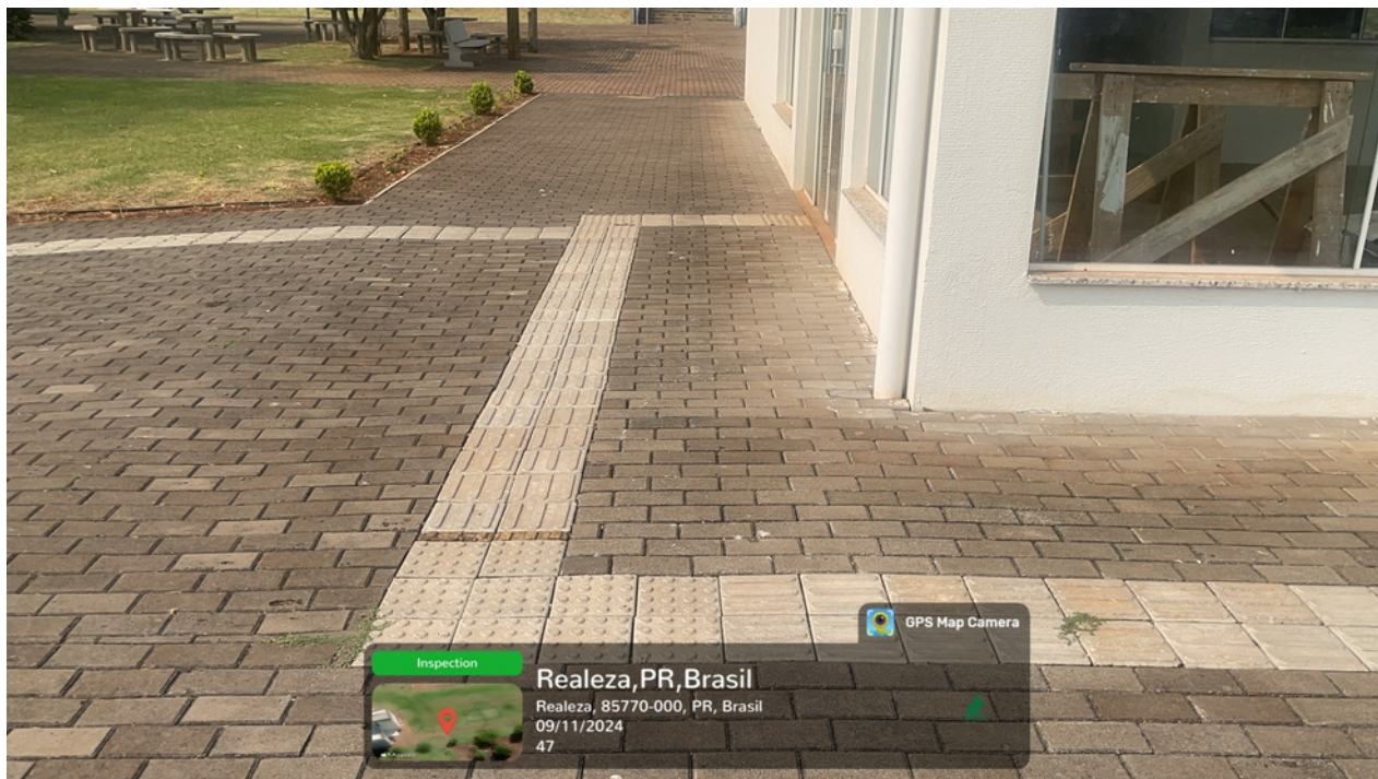
Figura 47 - Paver Lateral - Adequação as normas de acessibilidade (pintura e troca de pavers)
