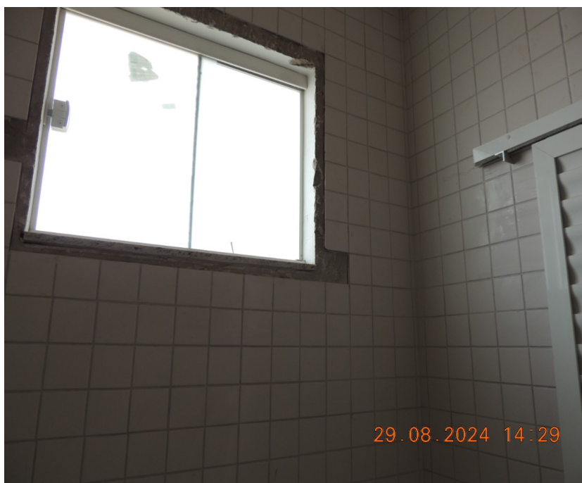
Foto 33- Finalização das instalações de azulejos nas bordas das janelas.
