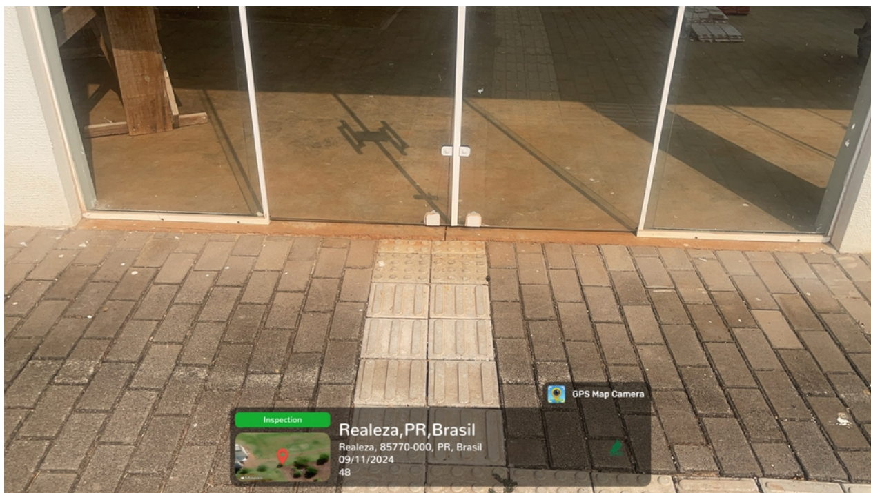
Figura 48 - Paver Lateral - Adequação as normas de acessibilidade (pintura e troca de pavers)
