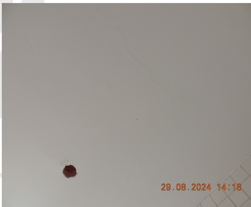
Foto 20 - Conserto de trincas na laje da cozinha, aplicar massa corrida e refazer a pintura.
