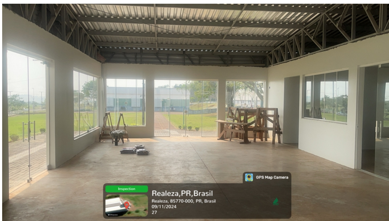
Figura 28 - Piso e teto Praça de Alimentação – Instalação elétrica, do forro, verniz no piso, podo tátil, luminárias de emergência.
