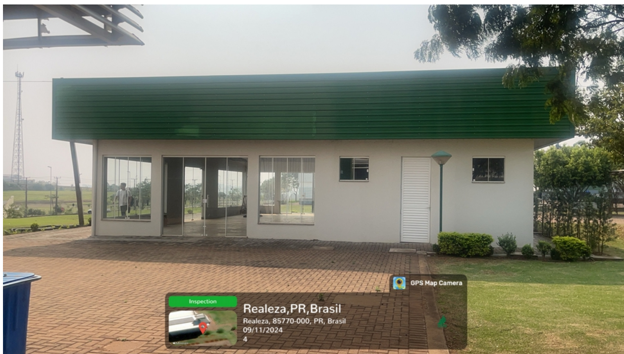
Figura 4 - Fachada lateral direita – Pintura da Platibanda, pintura externa e instalação de película nas janelas dos banheiros.
