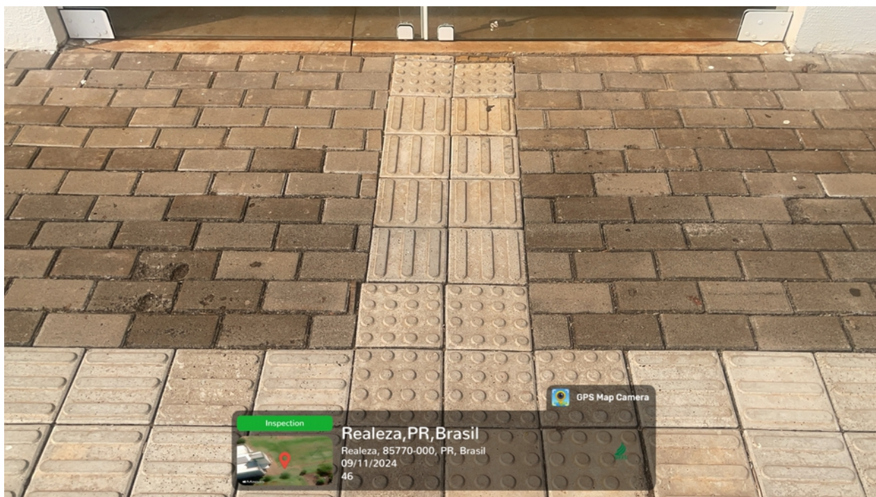
Figura 46 - Paver frontal – Adequação as normas de acessibilidade (pintura e troca de pavers)
