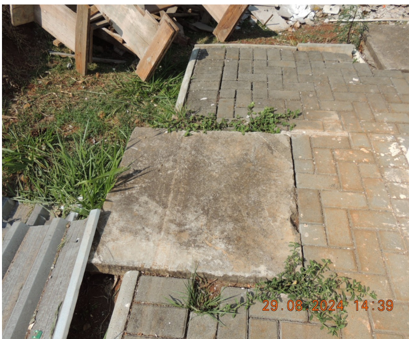
Foto 47- Confeção de colarinhos, tampas de concreto, finalização das calçadas em trono das caixas de gordura e caixas de inspeção.
