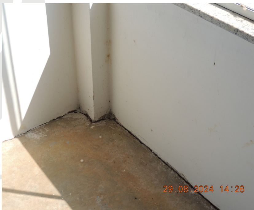
Foto 28 – Limpeza geral do piso, conserto de tricas e fissuras, e pintura com tinta epóxi.
