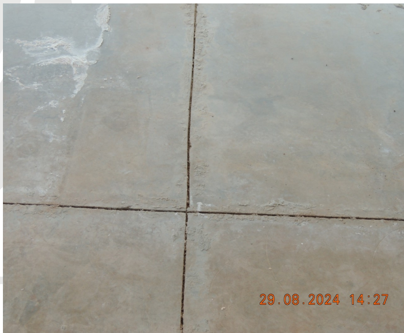
Foto 24 – Aplicação de selante elástico nas juntas de dilatação.
