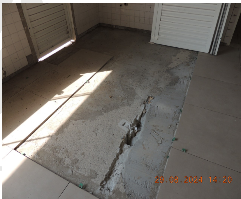
Foto 12 – Finalizar a instalação dos porcelanatos e instalar os ralos.
