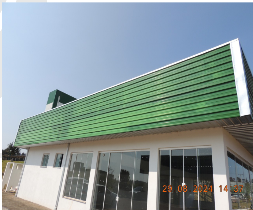
Foto 42- Substituição de fechamento dos cantos das platibandas.
