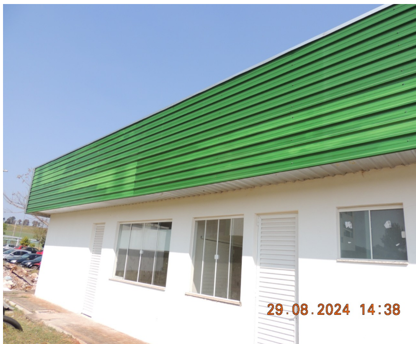
Foto 41- Pintura das platibandas em todas as fachadas do prédio.
