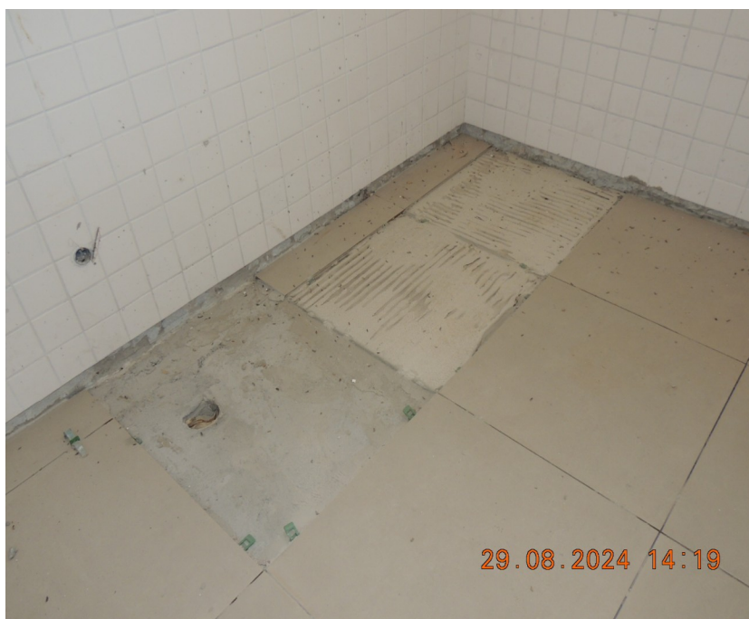
Foto 11 – Finalizar a instalação dos porcelanatos e rejuntar o piso.
