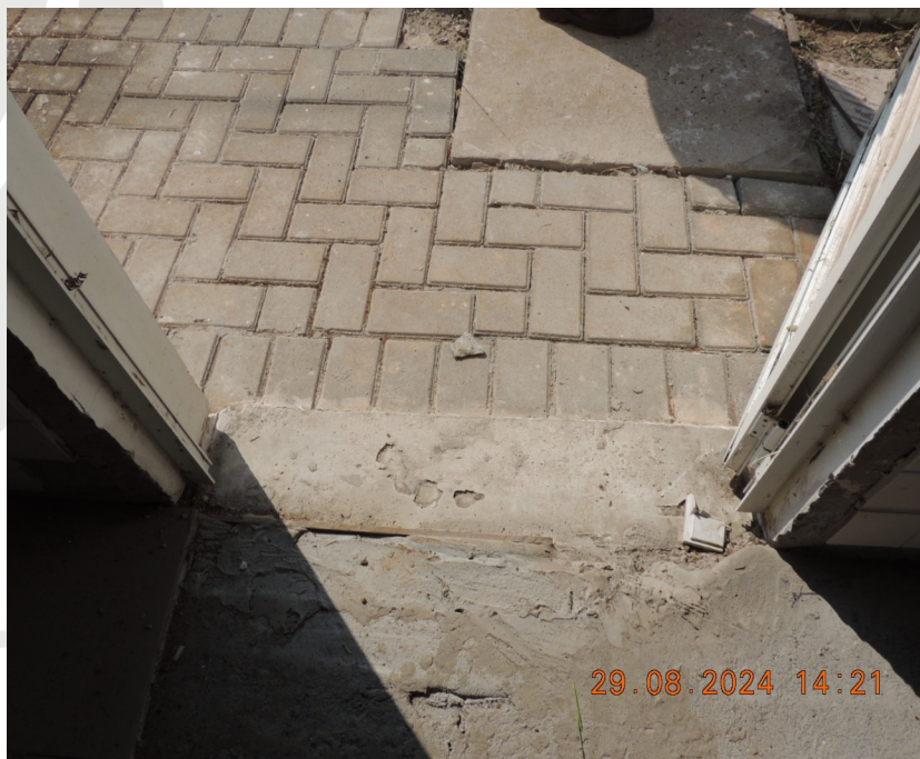
Foto 14 – Instalar as soleiras de granito, nas portas da cozinha e depósito.
