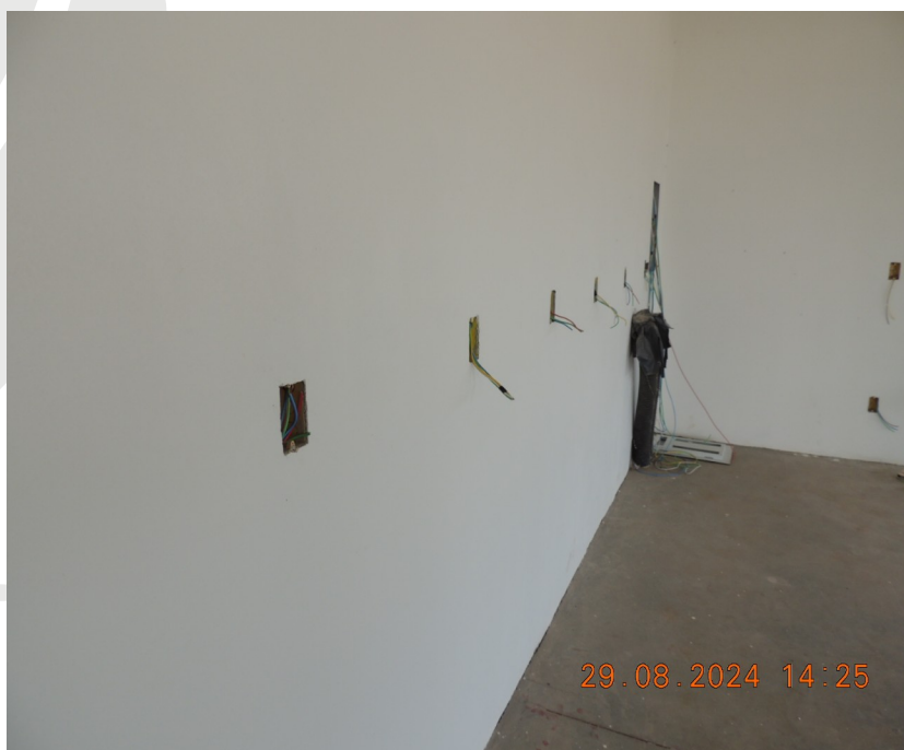
Foto 26 – Instalação de cabos, tomadas e interruptores.
