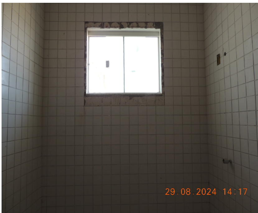
Foto 05 – Finalizar a instalação dos revestimentos cerâmicos nas molduras das janelas.
