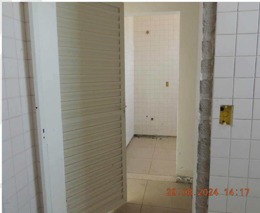
Foto 04 – Finalizar a instalação dos revestimentos cerâmicos nas molduras das portas.
