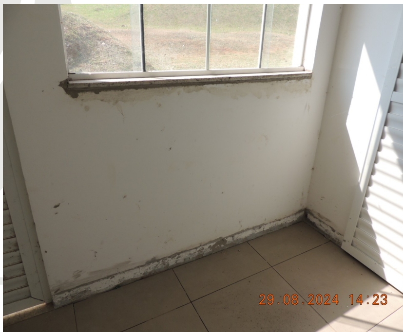
Foto 18 - Refazer o acabamento no peitoril da janela e pintar as paredes do depósito.
