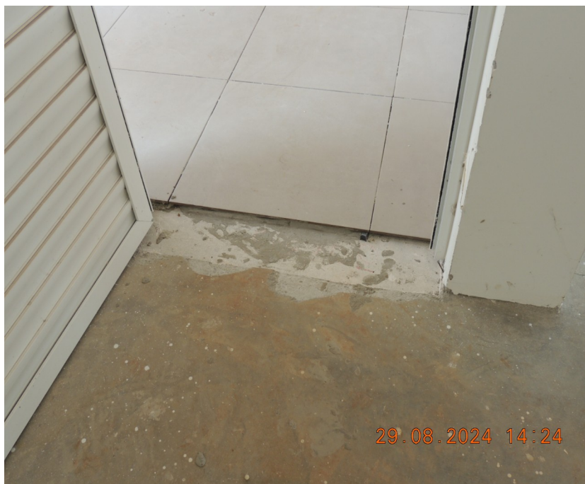
Foto 19 - Instalar soleira de granito na porta de acesso a cozinha.
