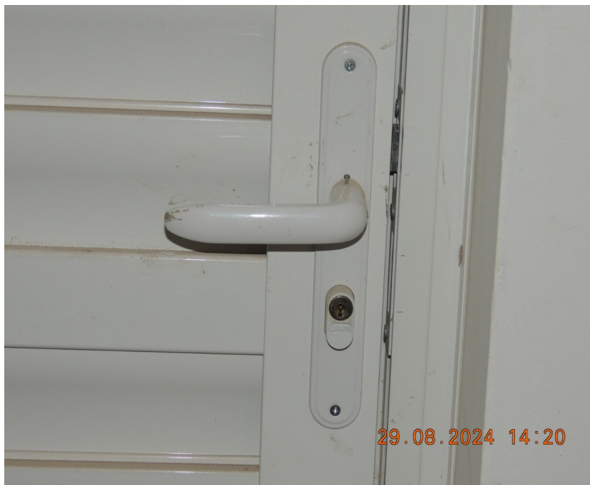
Foto 07 – Fazer a substituição dos cilindros das fechaduras que estão sem as chaves.
