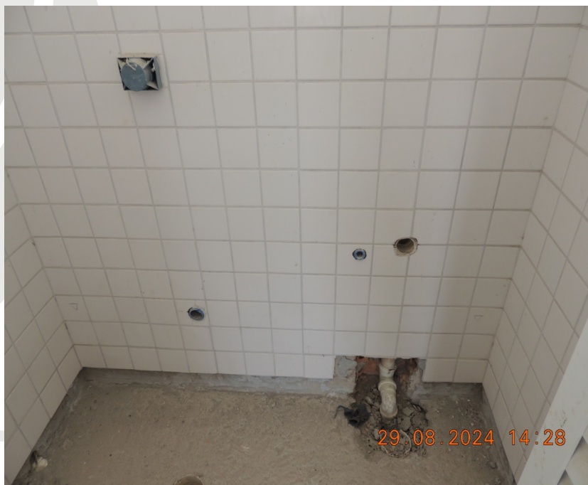
Foto 32- Revisão nas instalações hidrossanitárias, rede de esgoto e rede hidráulica.
