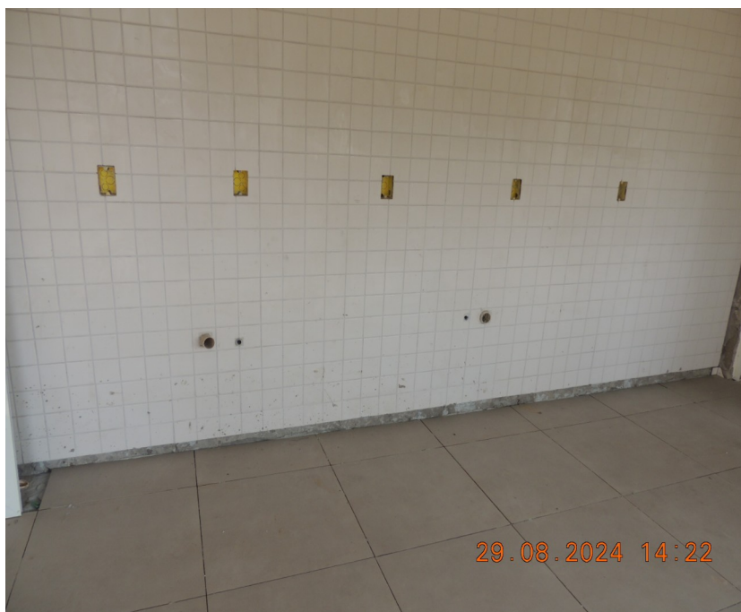
Foto 15 – Passar fiação instalar tomadas, interruptores e lâmpadas.
