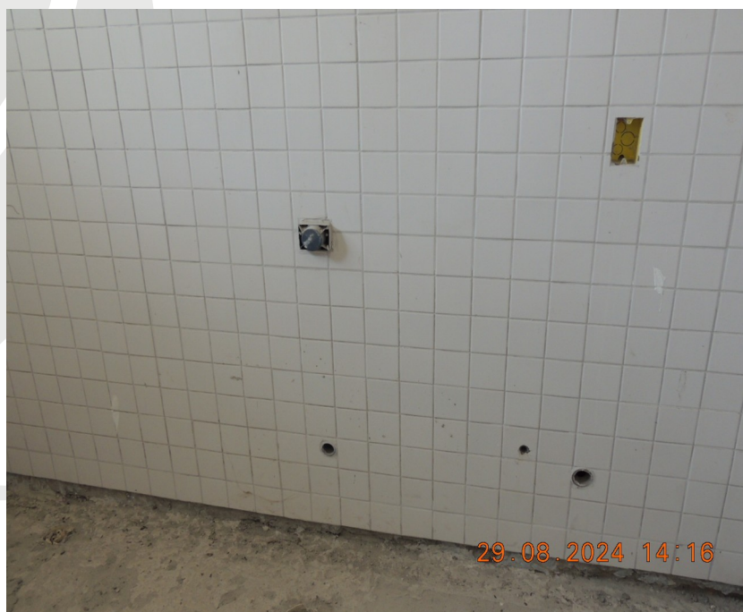
Foto 02 – Instalar louças sanitárias, vasos, pias, torneiras, acabamento de válvula de descargas.
