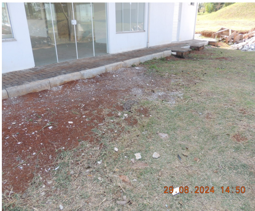
Foto 55- Reaterro, nivelamento do terreno e plantio de grama.
