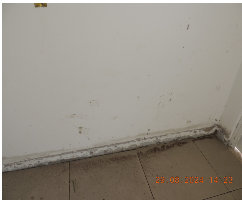
Foto 17 – Instalar rodapés, e rejuntar o piso do depósito.
