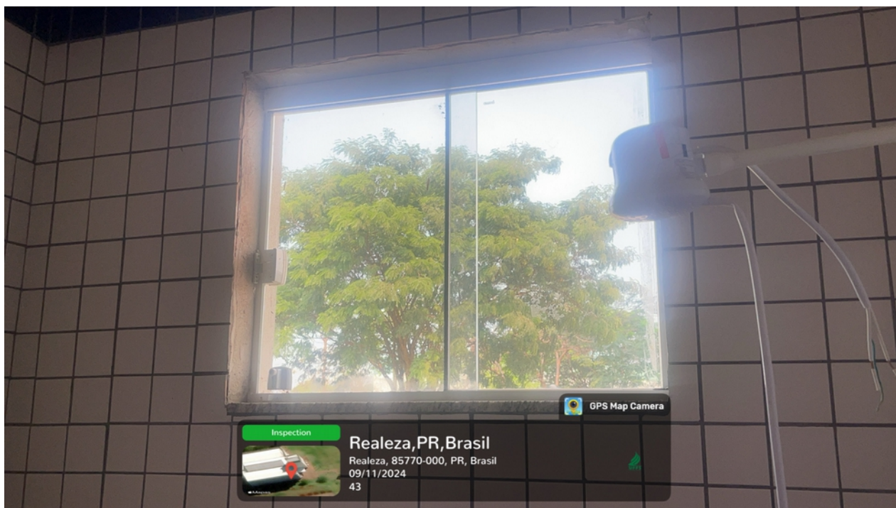
Figura 22 - Banheiro Masculino – Instalação de cerâmicas na janela.
