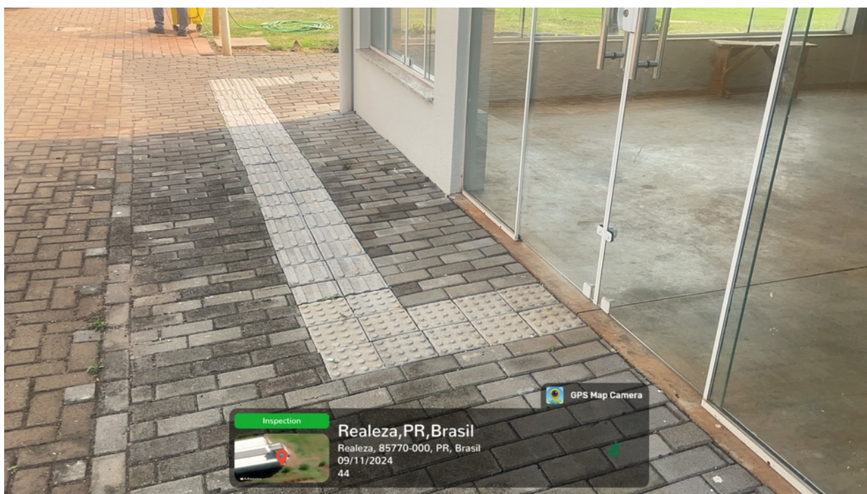
Figura 44 - Paver Lateral – Adequação as normas de acessibilidade (pintura e troca de pavers)
