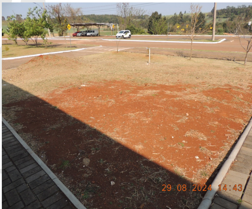
Foto 56- Reaterro, nivelamento do terreno e plantio de grama, nas áreas em trono do prédio.
