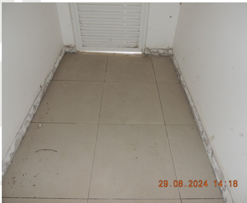
Foto 10 – Instalar os rodapés e rejuntar o piso de porcelanato no hall da cozinha.
