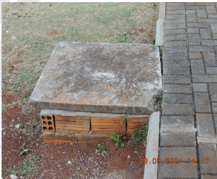
Foto 48- Finalizar o reboco nas laterais das caixas de inspeção de esgoto e elétrica.
