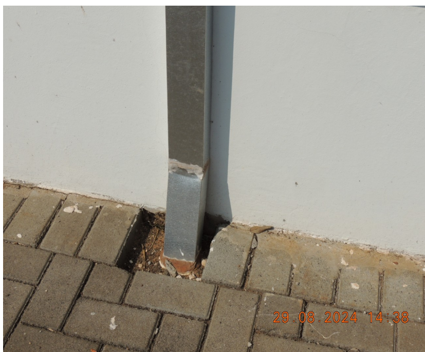
Foto 43- Instalação de joelho nas descidas das calhas, e finalização das calçadas de pavers.
