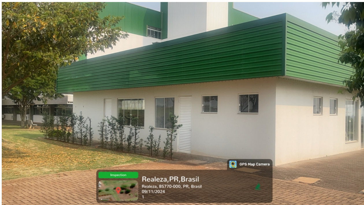
Figura 1 - Fachada Posterior – Pintura da Platibanda, colocação de tela mosquiteiro nas duas janelas (cozinha e depósito) e na porta da cozinha, pintura externa.
